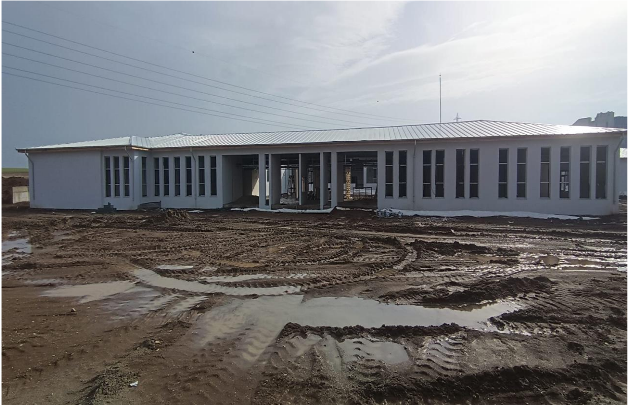
Veterinerlik Fakóltesi Hayvan Hastanesi İnşaatı
