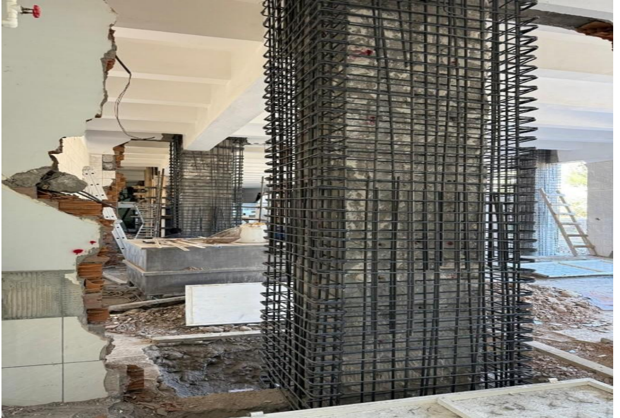
Veteriner Fakóltesi Deprem Güçlendirilmesi İnşaat
