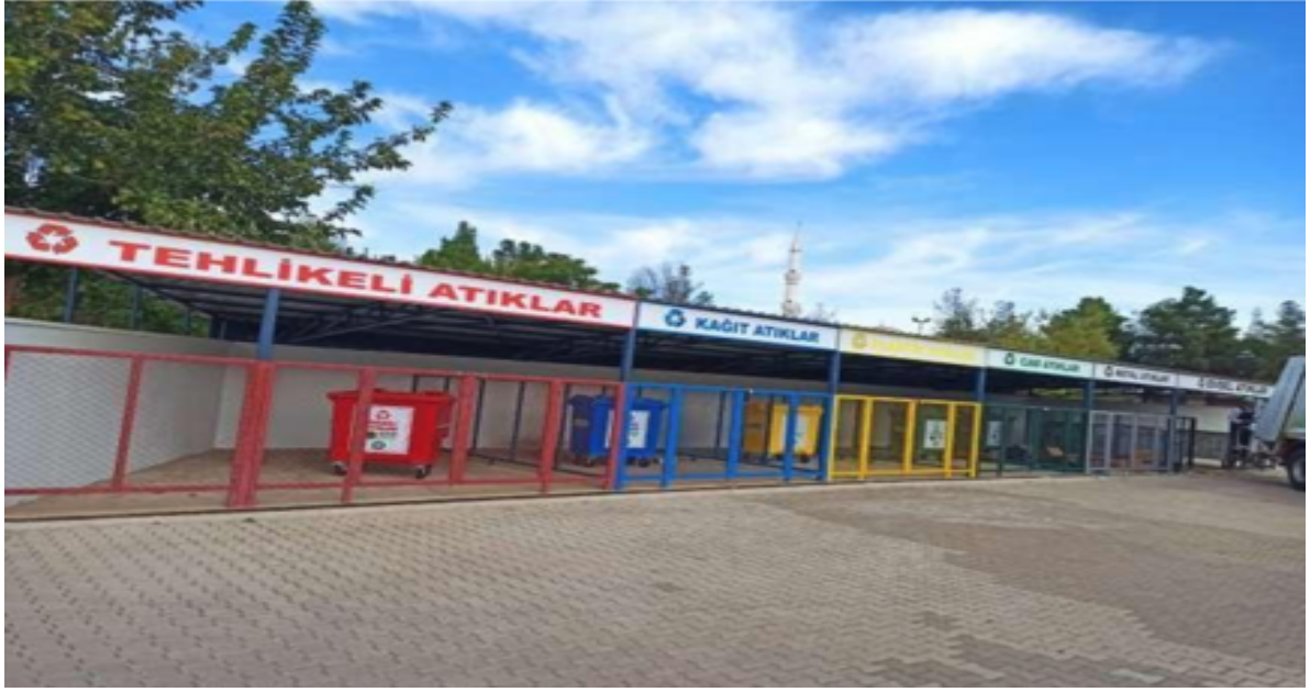
Şekil 7. Atık Geçici Depolama Alanı
