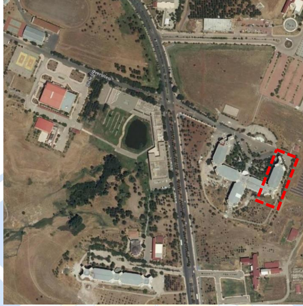
Şekil 10: Dicle Üniversitesi Mimarlık Fakültesi Hava Fotoğrafı
