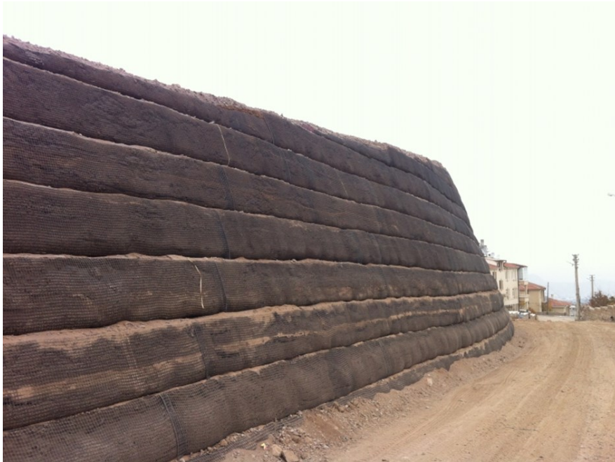
Şekil 2. Boğçalama tekniği ile inşa edilmiş geosentetik donatılı istinat duvarı
