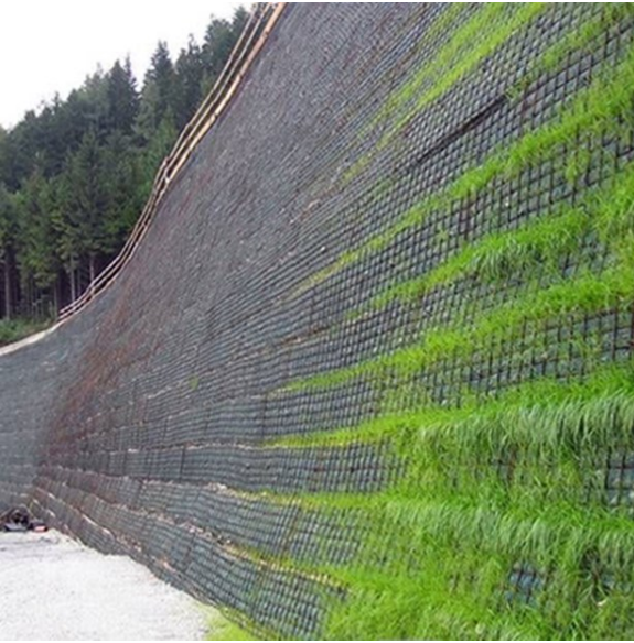
Şekil 3. Geosentetik donatılı istinat duvarı şematik gösterimi
