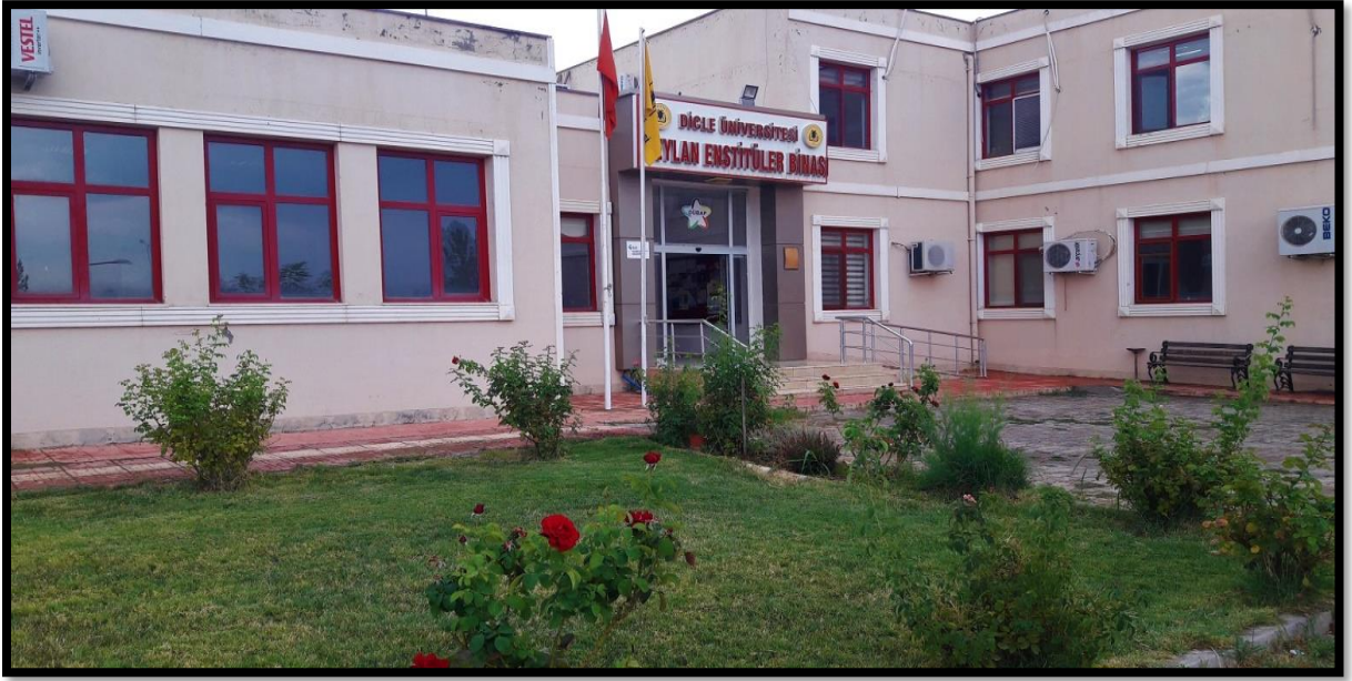
Ceylan Enstitüler Binası
