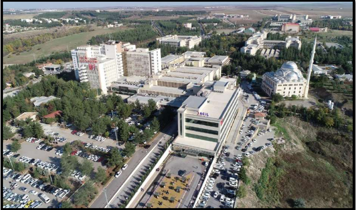
Dicle Üniversitesi Hastaneleri Merkez Binası
